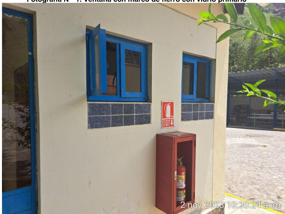
**Fotografía N° 2. Ventanas de hierro con vidrio primario**
